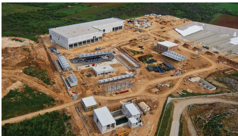
Slika br. 20: Izgradnja ŽCGO Kaštijun (G. Pula)
