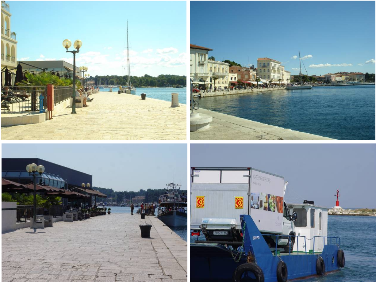
Slika 7. a, b, c i d Izgrađena obala na sjevernom dijelu ispred Hotela Palazzo, (ex Hotel Riviera)
