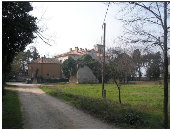
Slika 55. Pogled na začelje (istok) Ville San Lorenzo
