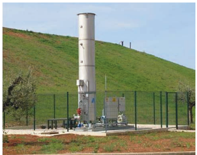
› Odlagalište Košambra kojim upravlja Usluga Poreč nakon provedene sanacije tijela odlagališta - kolna vaga na ulazu i sustav za otplinjavanje
