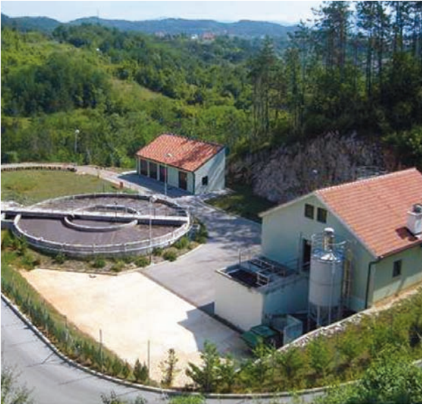
› L'impianto di depurazione delle acque reflue della città di Pisino
