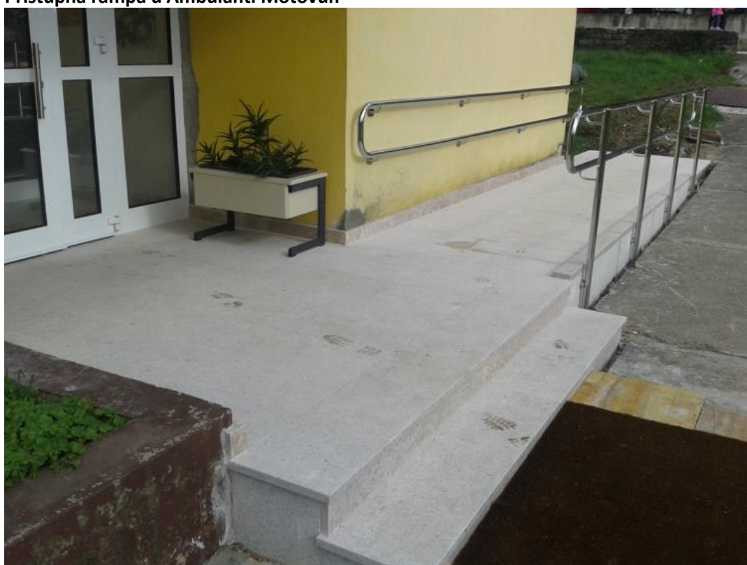
Pristupna rampa u Ambulanti Motovun
