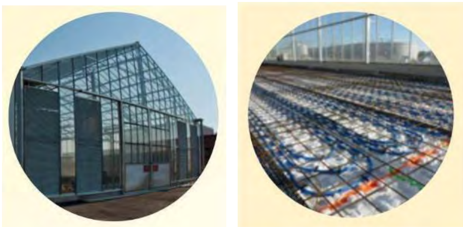
Slika 21. Staklenik za solarno sušenje mulja s toplinskim dogrijavanjem
