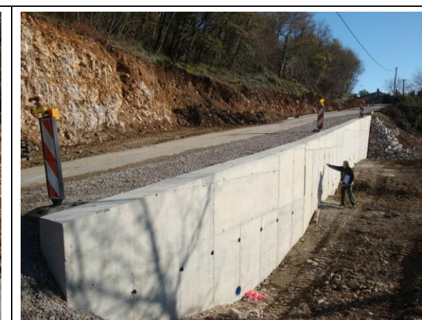
Slika 3.4.1.-6 Potporni zid - sanacija postojeće ceste u blizini navlačnog kontakta.
