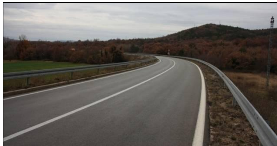
Slika 3.8.1-1. Lokacija za planirano kružno raskrižje kao početak predmetne spojne ceste na obilaznici Vranje (D500)
