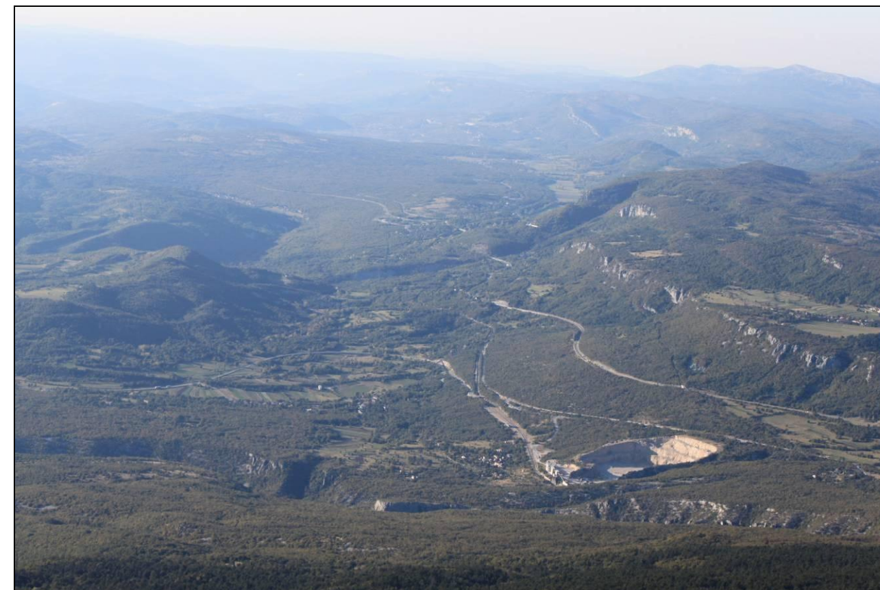
Slika 3.10.2-3. Pogled na lokaciju planirane ceste Lupoglav – Vranja (Foto: D. Oblijan, 29.06.2012.)
