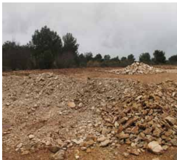
Slika 4: pogled na istočnu stranu
