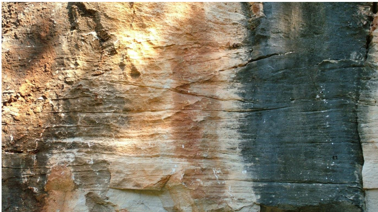
Slika 4. 13. Kosi setovi prudnih tijela u kamenolomu Marušići kao jedan od varijeteta različitih litotipova vapnenaca formacije Rušnjak. Foto: Matičec, D. i Fuček, L. (2012.).
