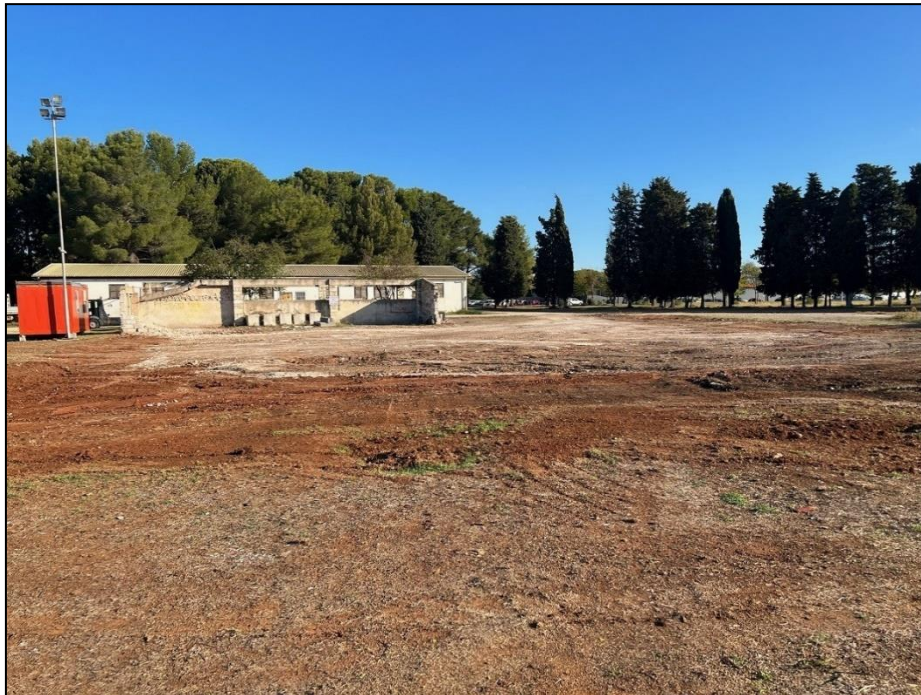
Slika 9. Akcija sanacije starog reciklažnog dvorišta
