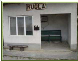
HŽ - ŽELJEZNIČKO STAJALIŠTE GORNJA NUGLA
