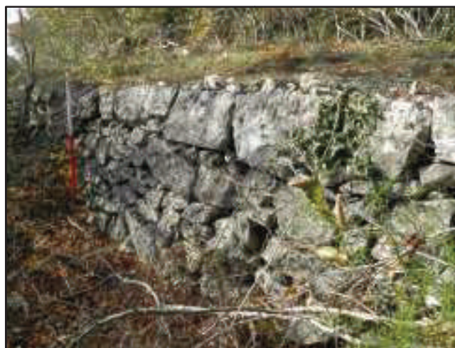
Slika 3.11.9. Kameni blokovi u podzidu ceste
