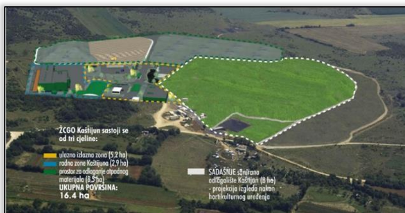
Slika 8. Zona za odlaganje otpada ŽCGO Kaštijun
